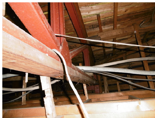
無柱を実現させるために鉄骨のトラスが使われている。
